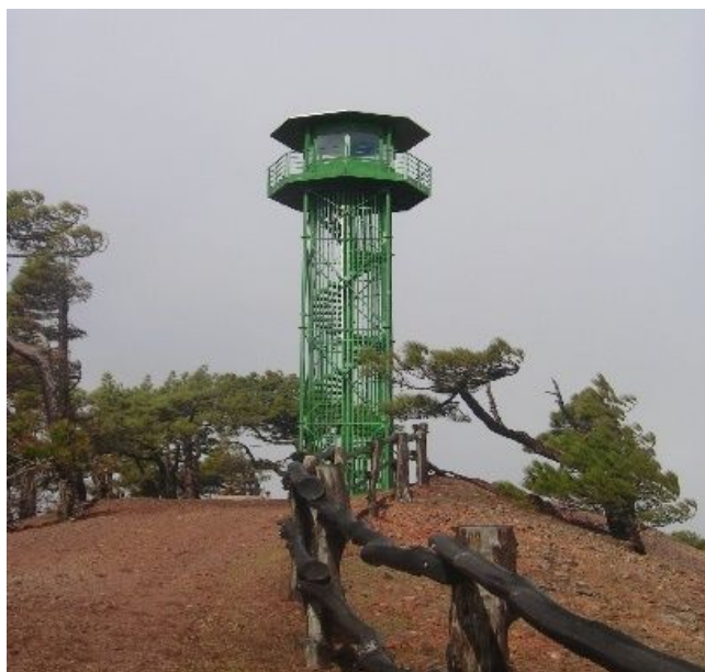
Imagen 4: Torre de Vigilancia "El Mercadel"
