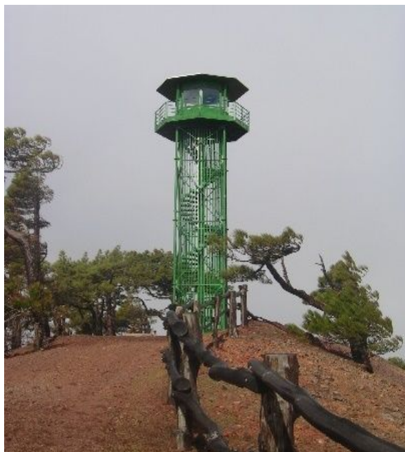
Imagen 1: Torre de Vigilancia "El Mercadel"
