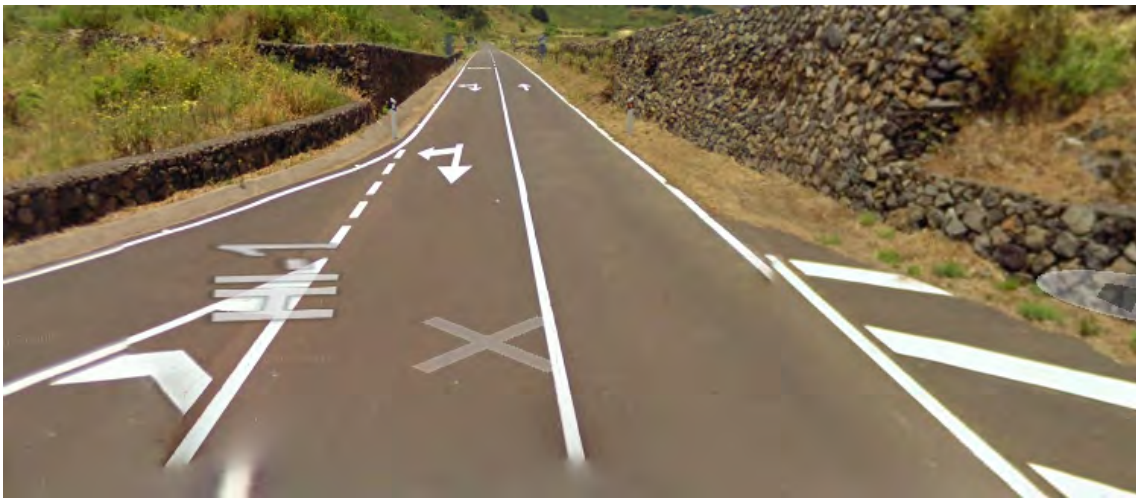
Imagen nº6: Final de actuación en la HI-1, en encuentro con HI-4.
