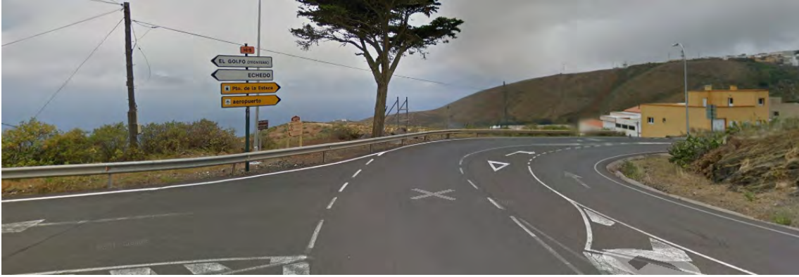
Imagen nº8: Final de actuación en la HI-2, en encuentro con HI-5.
