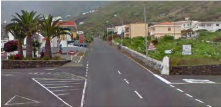
Imagen nº5: Inicio Actuación HI-1
