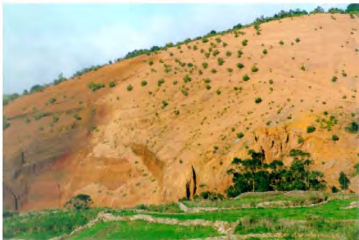
Procesos erosivos en ladera, carcavas
