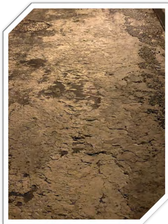
Imagen 7: Capa de Gunita en escamas sobre la superficie, graves irregularidades para la circulación
